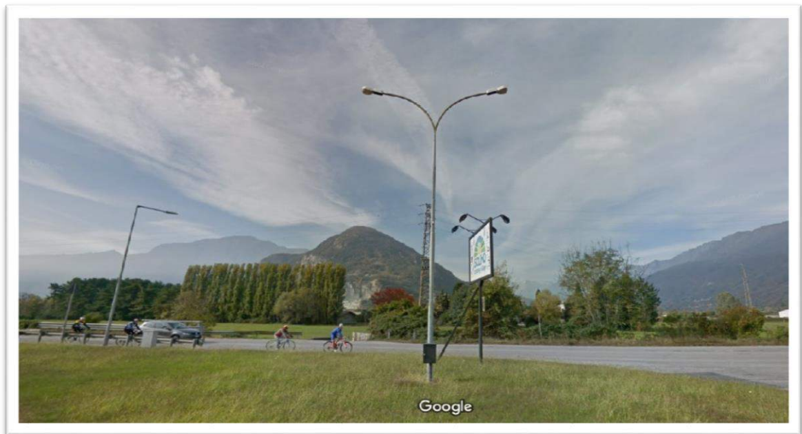
Zona Isolino, collegamento in F.O. con la rotonda e il TD4
