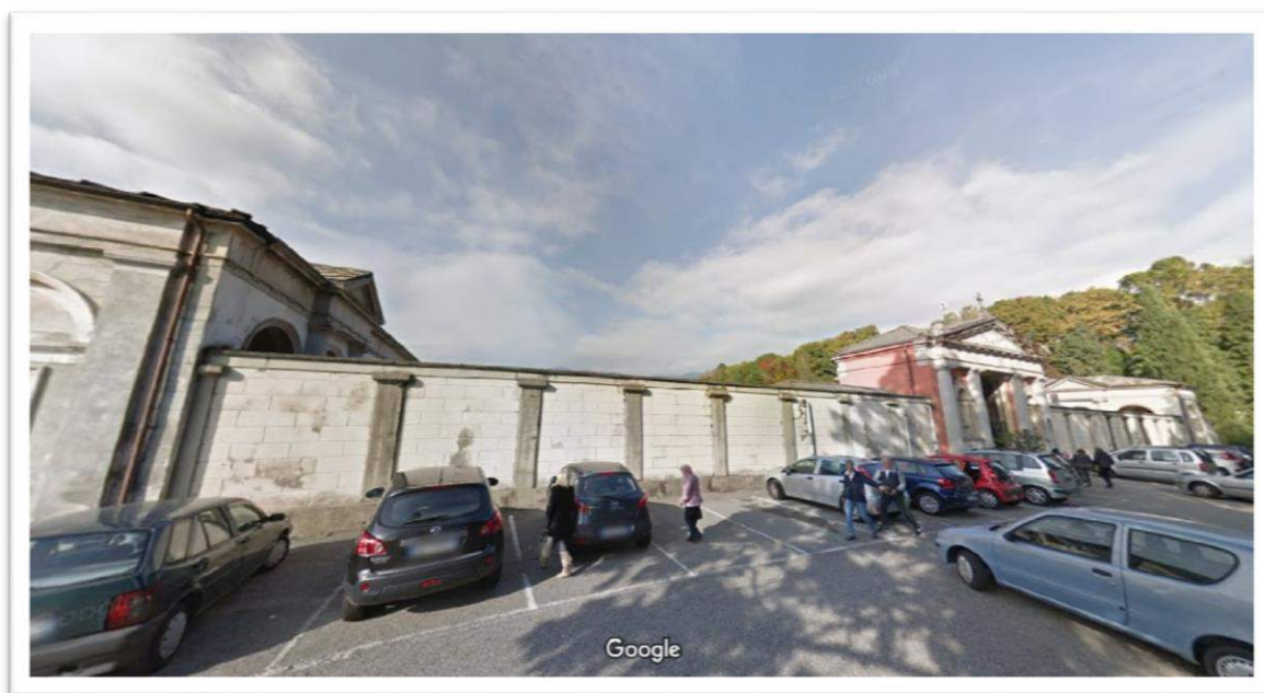
Cimitero di Intra, Via Farinelli, 10 - vista da sud
